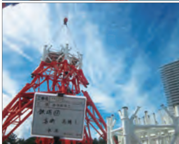
花見川中継局撤去完了（2020年12月）
