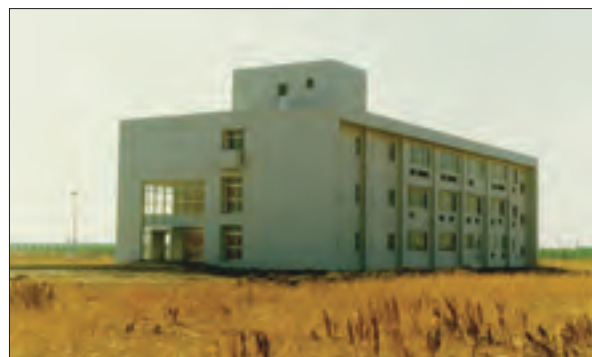
放送教育開発センター管理棟竣工（現・西管理棟）（1980年12月）
