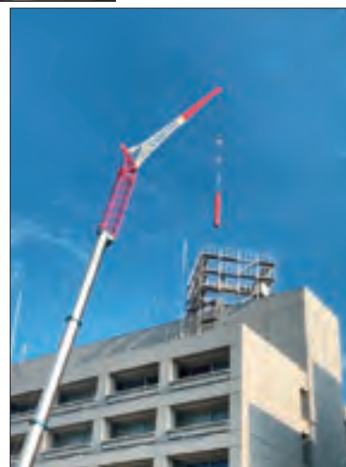
放送大学本部鉄塔撤去完了（2021年11月）
