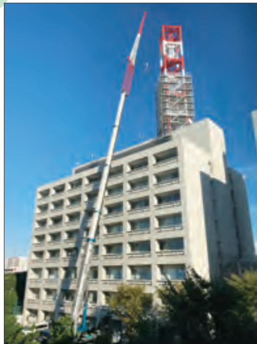
放送大学本部鉄塔撤去の様子（2021年）
