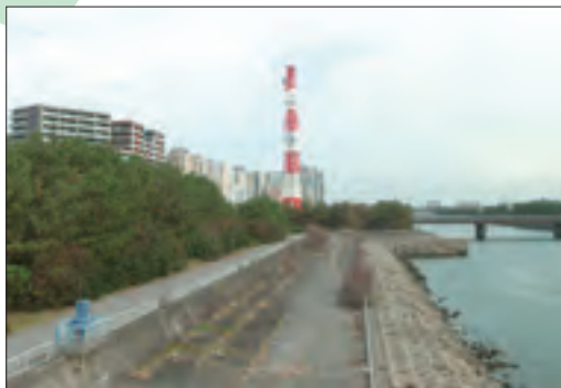
花見川中継局撤去の様子（2020年）
